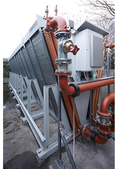
Rückkühler in V-Form mit drehzahlregulierten Lüftern, 560 kW
